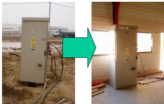
Odborne vykonaný presun rozvádzačov.
